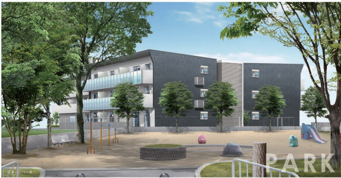
～北側には山北公園が隣接～
